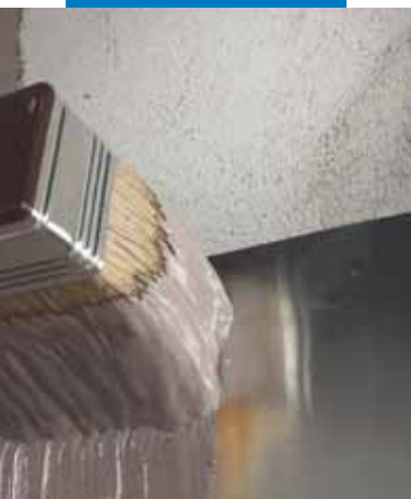
Rasatura e protezione di Mapeshield E 25 con Mapelastick Smart applicato a pennello
