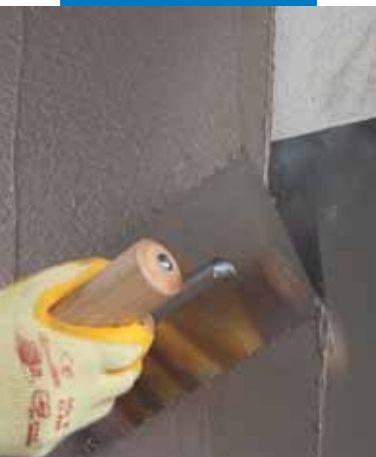
Rasatura e protezione di Mapeshield E 25 con Mapelastick Smart applicato a spatola
