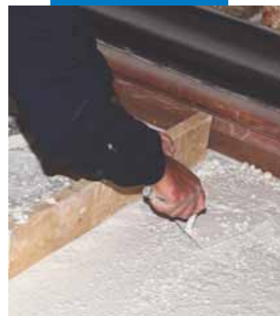
Staggiatura e compattazione di Ultratop in miscela con gli aggregati Dynastone Color
