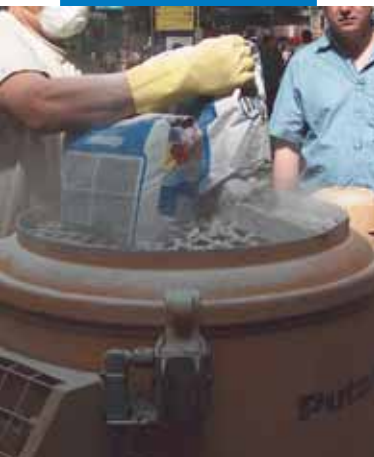
Preparazione di Ultratop a macchina
