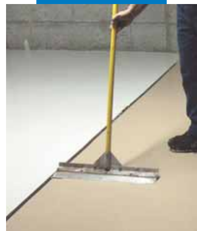
Lisciatura di Ultratop subito dopo la stesura
