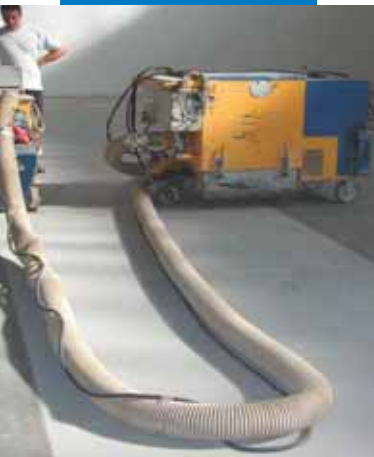
Preparazione del supporto mediante pallinatura
