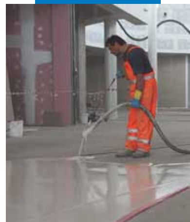
Applicazione a macchina di Ultratop
