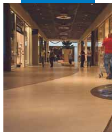
La pavimentazione finita in Ultratop
