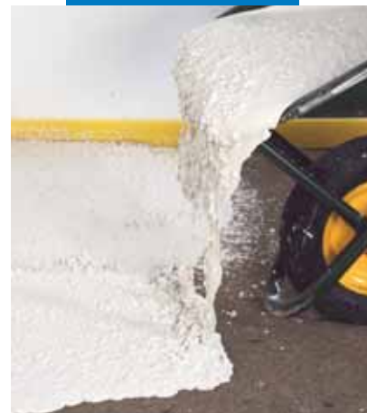
Stesura della miscela ottenuta con Ultratop e Dynastone Color
