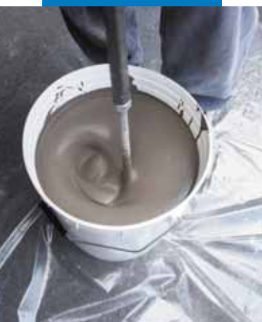
Preparazione del prodotto con trapano
