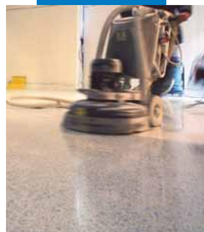
Fase finale della levigatura a secco della pavimentazione realizzata in Ultratop/ Dynastone Color
